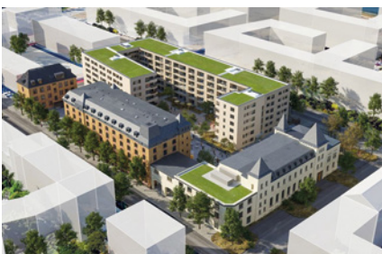
Das neue Quartier „Kommissbrotbäckerei“ (Copyright beide Abbildungen: ARGE LOOC/M Architektenpartnerschaft GmbH Vorbröcker Knoll, schneider + schumacher)
